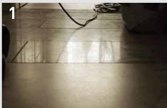
1 Stan wyjściowy: sucha i oczyszczona powierzchnia
